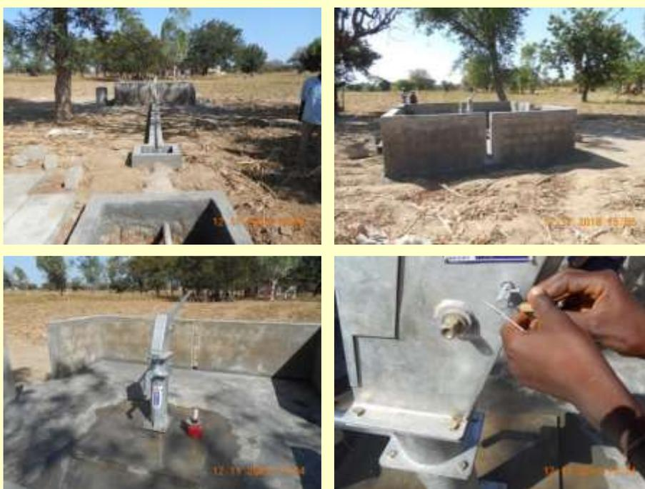
*Finalización del abrevadero y colocación de la bomba de agua*
